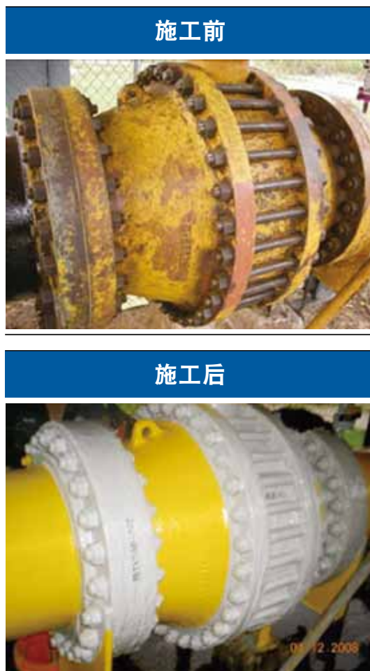
Figure5 防锈施工示例
