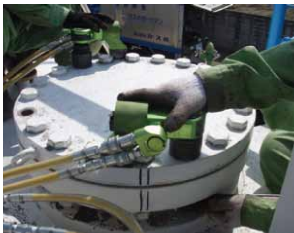
Figure2 油圧トルクレンチ2台による並行締め
