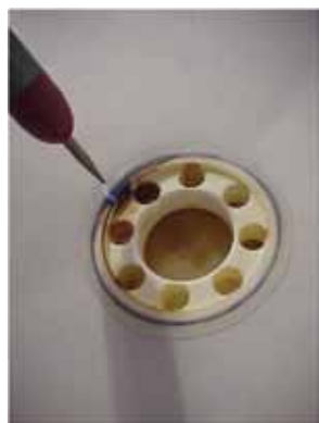
Figure 17 原因是集液槽与板材焊接部的破损
