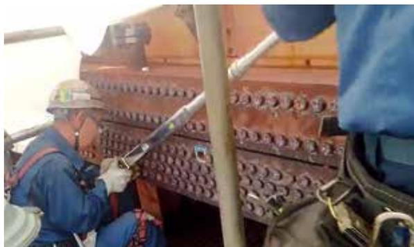
Figure1 従来の締付けの様子
