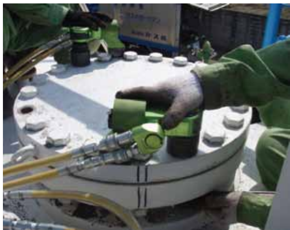
Figure2 使用2台液压扭矩扳手同时紧固
