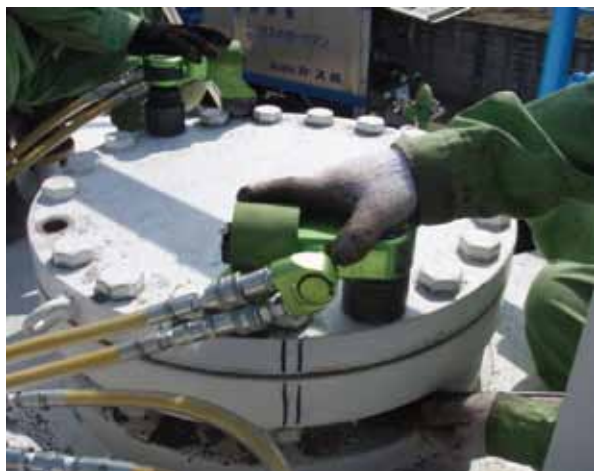
Figure2 使用2台液压扭矩扳手同时紧固
