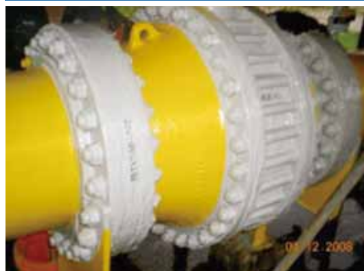
Figure5 防錆施工例
