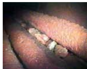
Figure7 洗浄前の状態
