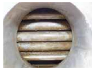
Figure6 洗浄後の状態
