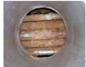
Figure3 洗浄前の状態
