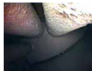
Figure8 洗浄後の状態
