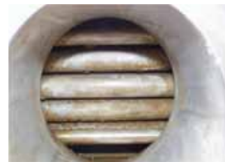
Figure6 洗浄後の状態
