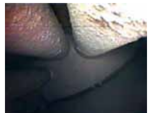
Figure8 洗浄後の状態
