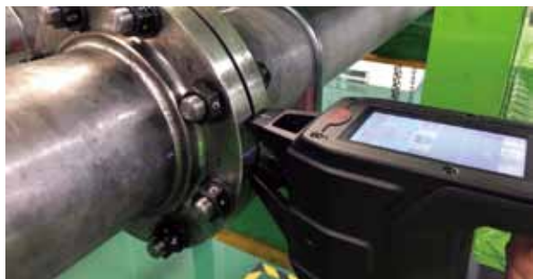
Figure3 法兰面间尺寸与段差的拍摄
