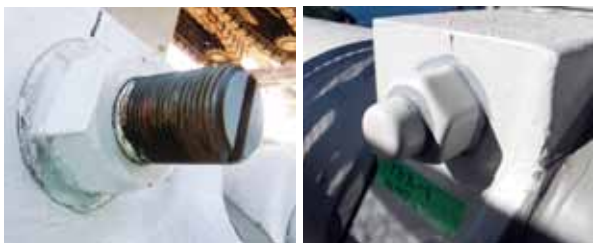
Figure 11 左 拆去M42尺寸现有盖帽后，存在部分生锈问题 右 分割型防锈盖的安装情况(由客户自行安装)
