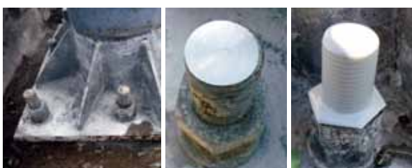
Figure 12 左 基础支撑螺栓(土中或空气中) 中 探伤试验时，对头顶部进行研磨并测定 右 探伤试验结束后，防锈盖的安装情况(由客户自行安装)
