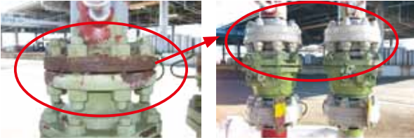
Figure5 开放法兰部施工前 仅开放部位涂覆
