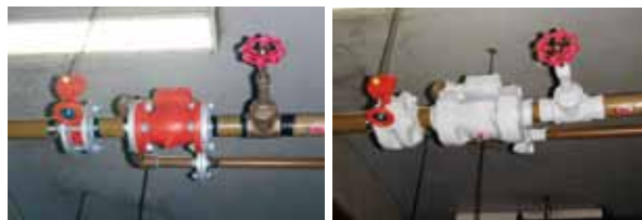
Figure4 施工前(配管施工后)
