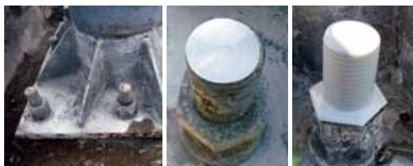
Figure12 左 基礎支持ボルト(土中または気中) 中 探傷試験時に頭頂部研磨し測定 右 探傷試験終了後、防錆キャップの設置状況(お客さま設置)
