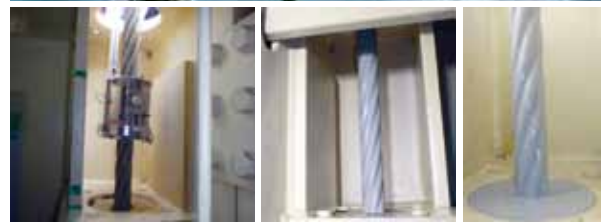
Figure9 ワイヤー表面の形状に合わせた、浸漬装置を開発した外面被覆防錆工法(当社特許技術)
