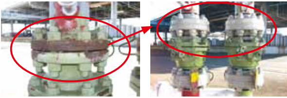
Figure5 開放フランジ部施工前 開放箇所のみ塗布
