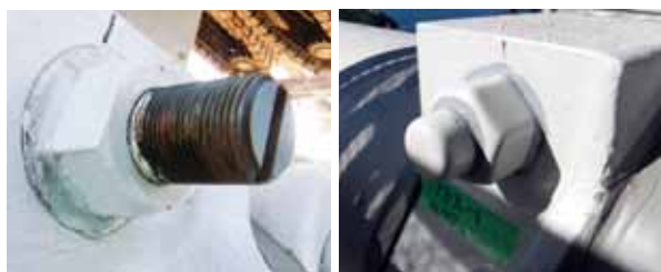
Figure11 左 M42サイズ既存キャップを撤去したところ、一部サビ発生 右 分割型の防錆キャップの設置状況(お客さま設置)
