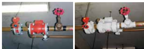
Figure4 施工前(配管工事後)
