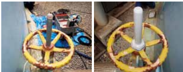
Figure7 スピンドル部防錆 塗布後(固化しないので操作可能)
