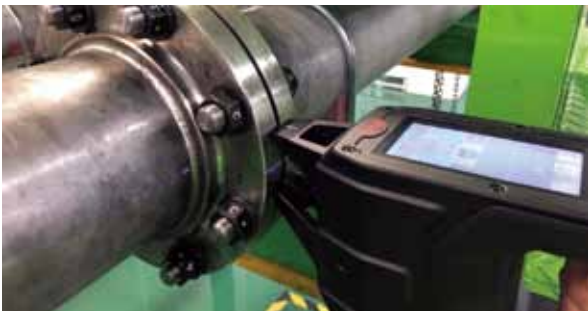
Figure3 フランジ面間・段差の撮像
