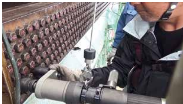
Figure3 使用手持式螺母扳手进行作业时的情景
