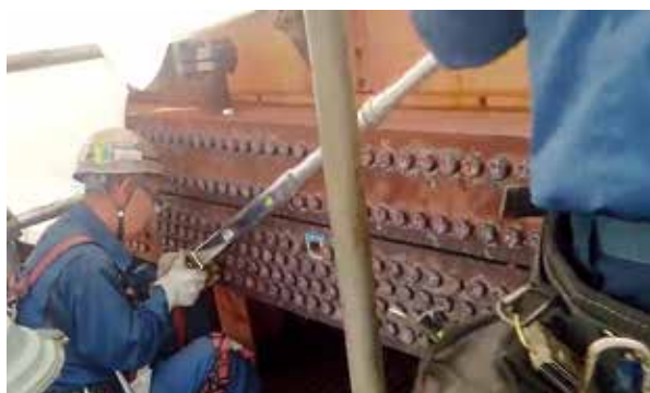
Figure1 従来の締付けの様子
