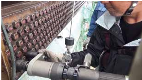
Figure3 ハンドナットランナーでの作業の様子
