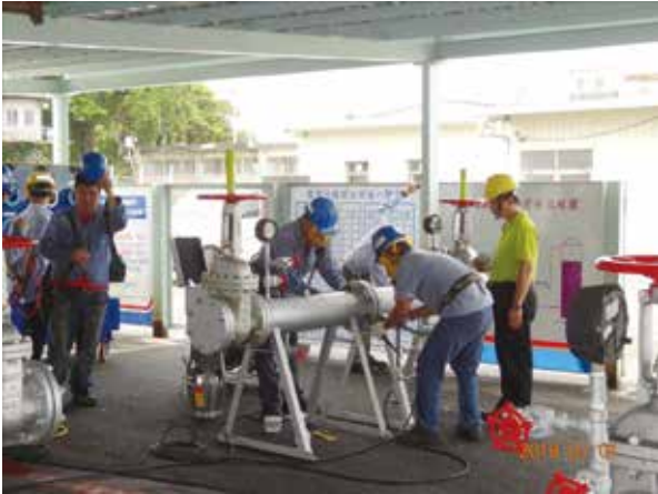
Figure7 請負業者のフランジ脱着トレーニング
