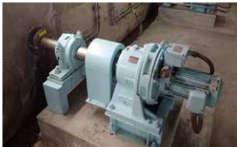
Figure1 フロキュレーター駆動装置
