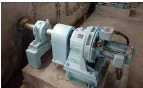
Figure1 フロキュレーター駆動装置
