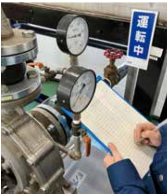
Figure1 記録用紙による点検作業イメージ
