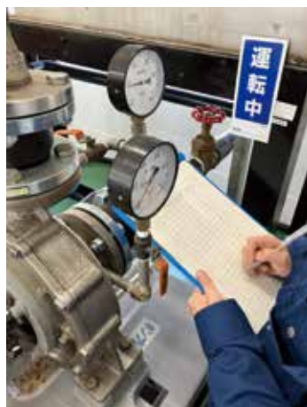
Figure1 記録用紙による点検作業イメージ
