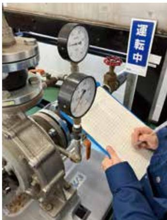
Figure1 記録用紙による点検作業イメージ
